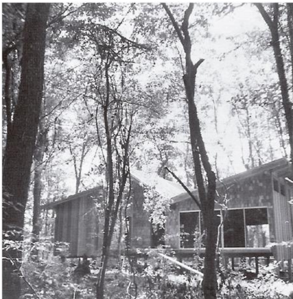
O Templo do Universo, com seu dinâmico telhado borboleta, sendo construído em 1975.
